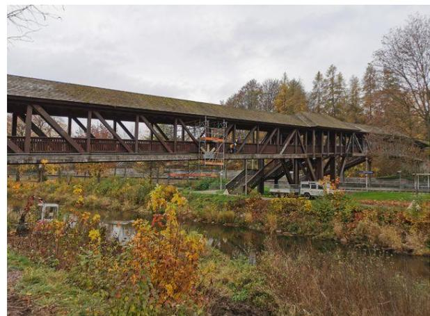
2020 November, Ausbau Belagsabdeckung über Knoten, außen und Überprüfung durch Industrie-Kletterer, Feststellung von weiteren 2 durchgefauten Knotenpunkten, Nordostseite
