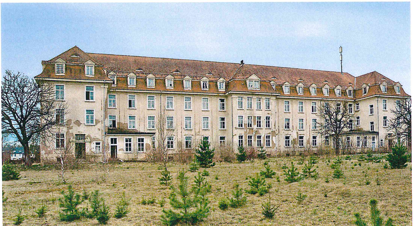
5 Kaserne Villingen, Mannschaftsgebäude, Fassade zum Exerzierplatz.
