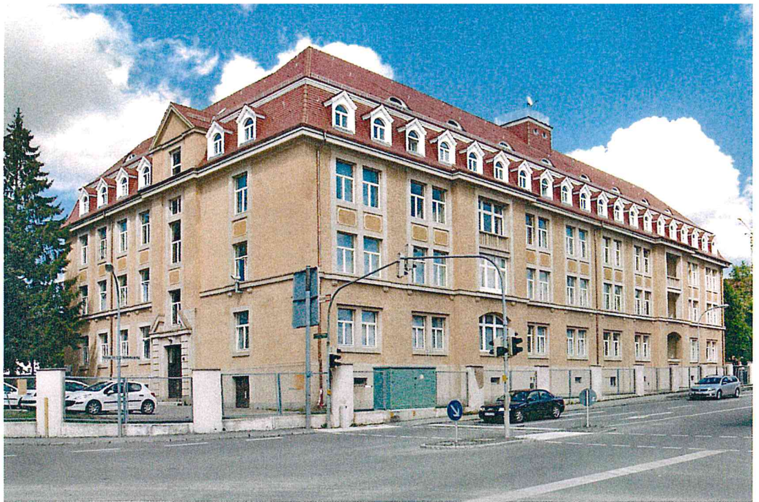
11 Kaserne Donaueschingen, Mannschaftsgebäude, Straßenfassade.
