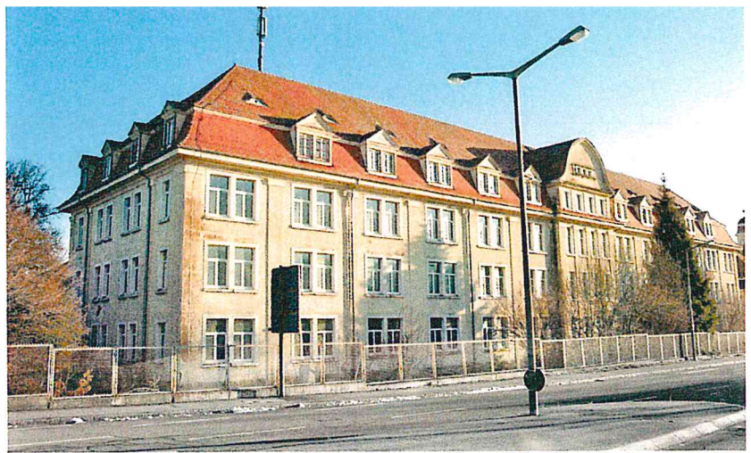
4 Kaserne Villingen, Mannschaftsgebäude, Straßenfassade.
