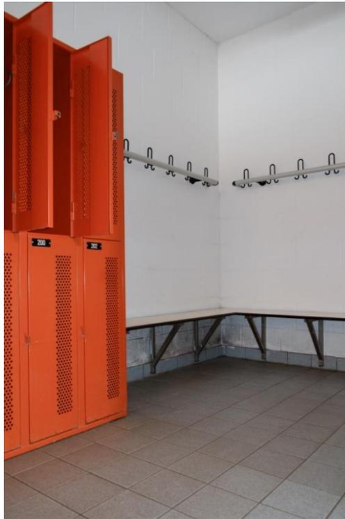
WC Bereich: Hier ist die Erneuerung der Bodenfliesen sowie Malerarbeiten vorgesehen. Auch die Umkleiden sollen einen neuen Anstrich erhalten. Um die Luftfeuchtigkeit zu verringern und Schimmelbildung in den Umkleiden und Sanitärräumen zu vermeiden, soll eine mechanische Entlüftung eingebaut werden.
