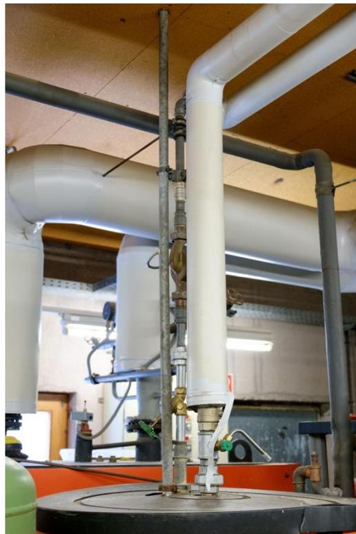
Heizzentrale: Der Heizkessel und Becken- und Warmwasseraufbereitung ist 30 Jahre alt und soll durch moderne Technik ersetzt werden. Heizkessel sind nach 25-30 Jahren am Ende ihrer Laufzeit angekommen. Die Erneuerung des Heizkessels kann unabhängig von eventuellen späteren Eingriffen in die Badwassertechnik erfolgen.
