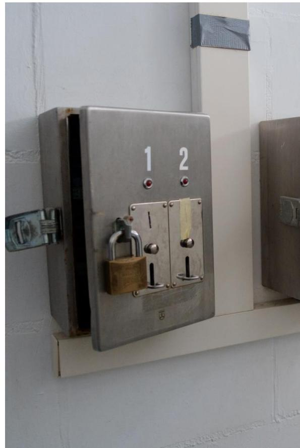
Sanitär, Duschen: Statt des anfälligen Münzsystems sollen Selbstschlussarmaturen zum Einsatz kommen. Das komplette Frischwasser-Leitungssystem muss erneuert werden, da im Bestand verzinkte Leitungen verbaut sind. Dies ist nach Trinkwasserverordnung (TWVO) nicht mehr zulässig. Die Duschbereiche sollen komplett neu gefliest werden und einen neuen Anstrich erhalten.
