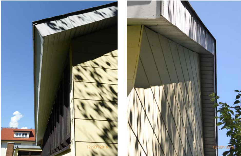
Abb. 2 + Abb. 3 geschlossene Fassaden und Dachkonstruktion
