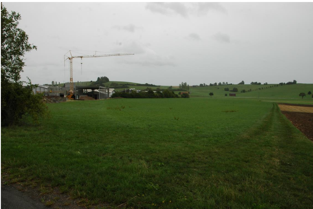
Blick von Westen auf das Plangebiet, links ein im Bau befindliches Gebäude, das in das Plangebiet hineinragt
