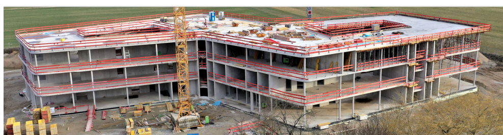
Bild Rohbau (Quelle: website hotz+architekten, aufgerufen am 27.04.2021)
