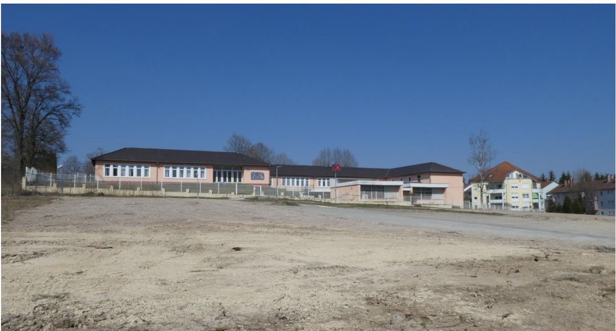
Abb. 6: Blick auf die Schule und den (zwischenzeitlich abgebrochenen) deutsch-französischen Kindergarten Richtung Norden Foto bhm
