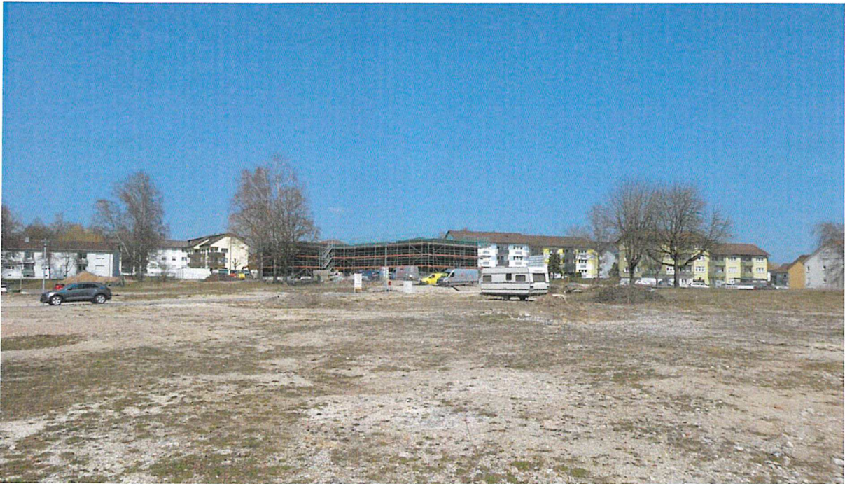
Abb. 3: Blick Richtung Norden auf die im Bau befindliche Kindertagesstätte Foto bhm
