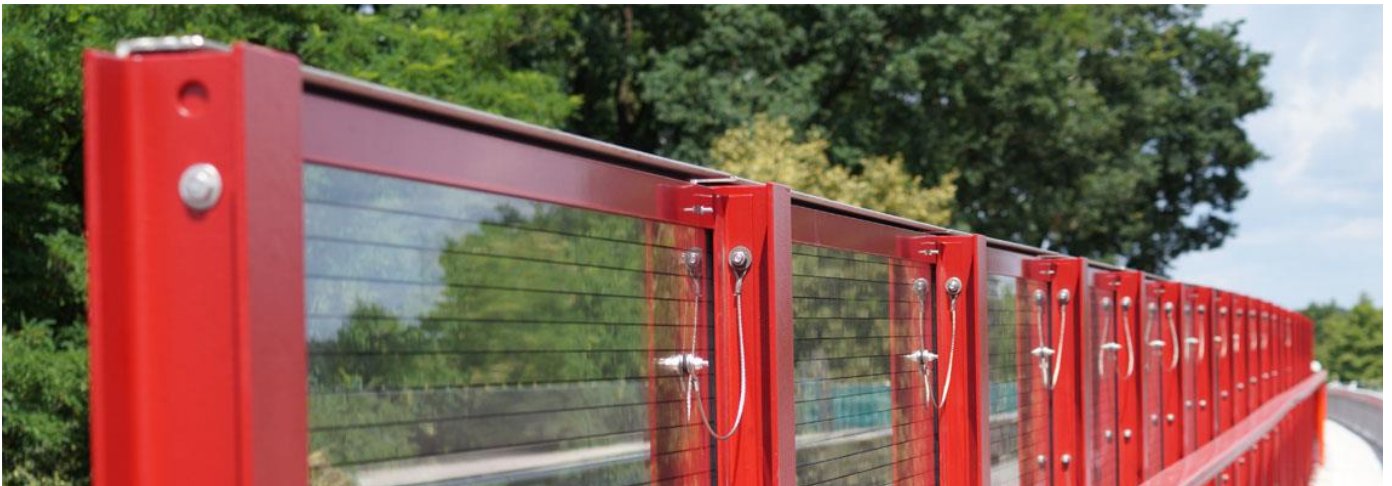
Abbildung 4-9: Berührungsschutzwand aus Acrylglas mit innenliegenden Stabilisierungsfäden, Quelle: https://www.bongard-lind.com/globalassets/bongard-lind/produkte/1_beruehrungsschutz.jpg
