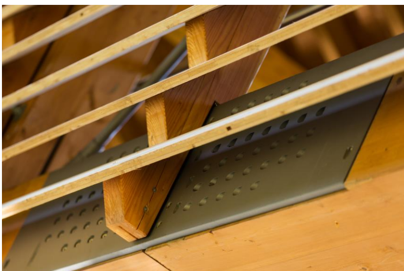
Abbildung 4-3: Fachwerkbrücke in Lörrach mit offenem Wetterschutz Quelle: https://www.schmees-luehn.de/wp-content/blogs.dir/1/files/neubau-bruecke-itzig/bruecke_loerrach_print-18.jpg
