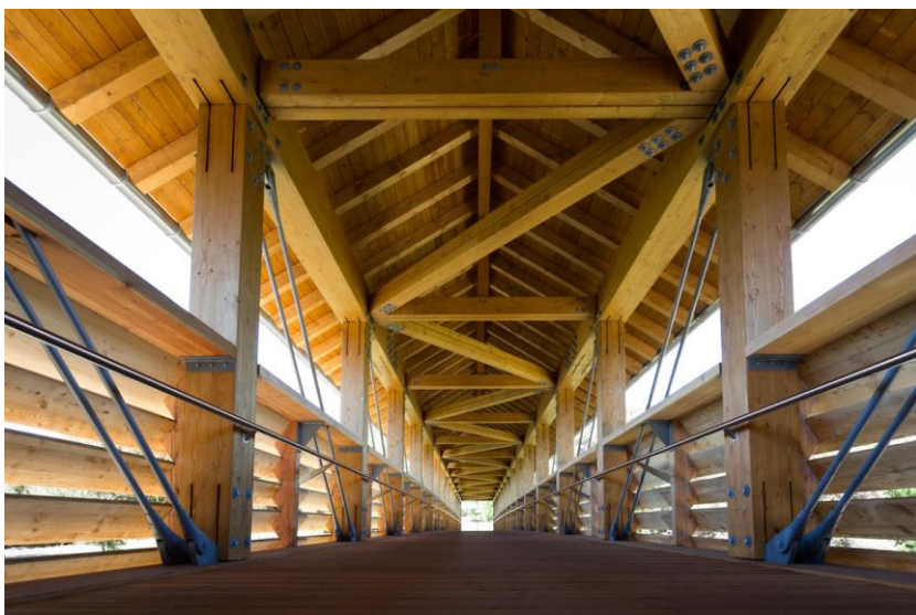
Abbildung 4-2: Fachwerkbrücke in Lörrach mit offenem Wetterschutz Quelle: https://www.schmees-luehn.de/wp-content/blogs.dir/1/files/neubau-bruecke-itzig/bruecke_loerrach_print-37.jpg
