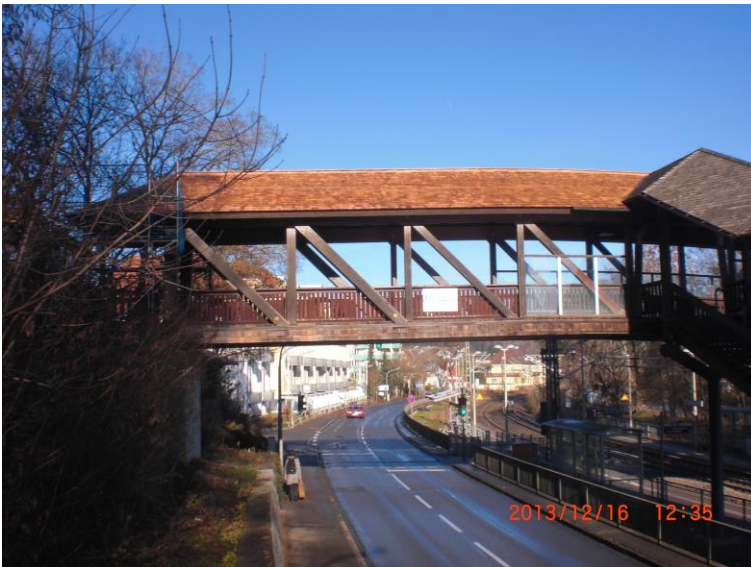
Abbildung 3-2: Erneuerte Holzschindeldeckung über dem westlichen Zugangsbereich
