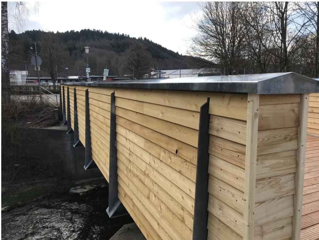
Abbildung 4-4: Eitabrücke Tuttingen, Foto: BI
