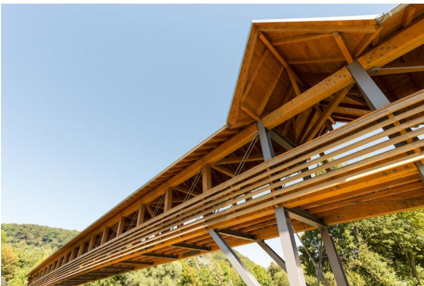
Abbildung 4-1: Fachwerkbrücke in Lörrach mit offenem Wetterschutz Quelle: https://www.schmees-luehn.de/wp-content/blogs.dir/1/files/neubau-bruecke-itzig/bruecke_loerrach_print-37.jpg
