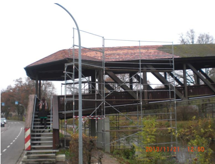
Abbildung 3-3: Erneuerte Holzschindeldeckung über dem östlichen Zugangsbereich
