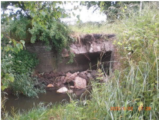
Ansicht Oberstrom-Rechts, Scheitelausbruch
