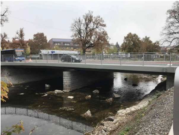
Ansicht Oberstrom Rechts 28.10.2021 (H1-Prüfung)
