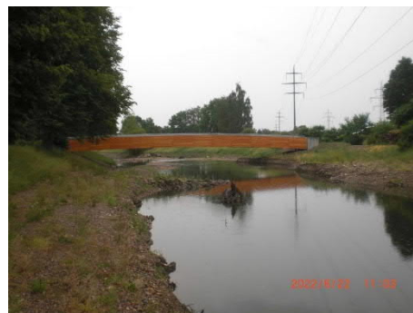
Ansicht Südwest (Oberstrom)
