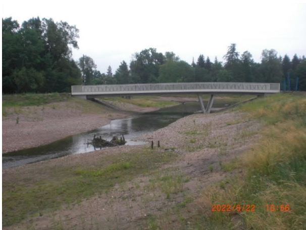
2022-06-22 Ansicht Süd (Oberstrom)
