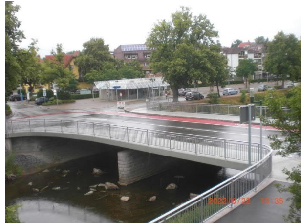
Ansicht Südwest, nach Instandsetzung 22.06.2022
