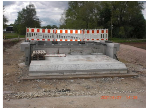
2021 Ansicht Rückseite Widerlager Ost (Seite Kläranlage)
