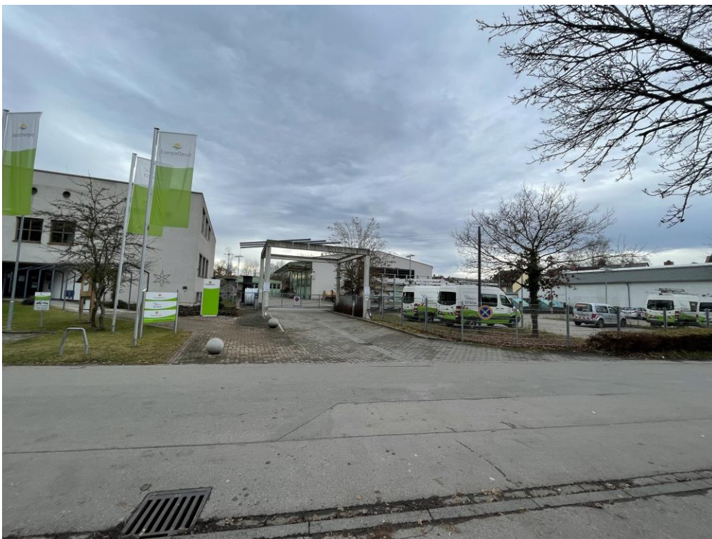
Bebauung sowie offene Lager- und Abstellflächen der Fa. Energiedienst AG
