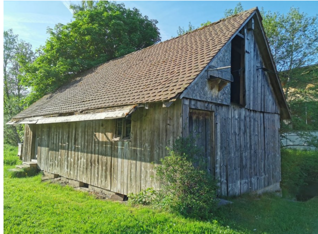
Abb. 23 Das Schuppengebäude auf Flst. Nr. 214/3 dient der Lagerung von diversen Materialien.
