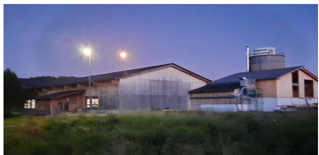
Abb. 21 Bei Nacht beleuchtetes Betriebsgelände. Aufnahme aus den Sommermonaten vom 13.06.2022.
