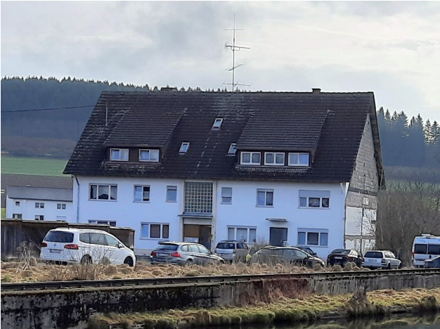
Abb. 22 Eines der Bestandsgebäude. Dieses Gebäude auf Flst. Nr. 214/4 wird derzeit noch bewohnt.
