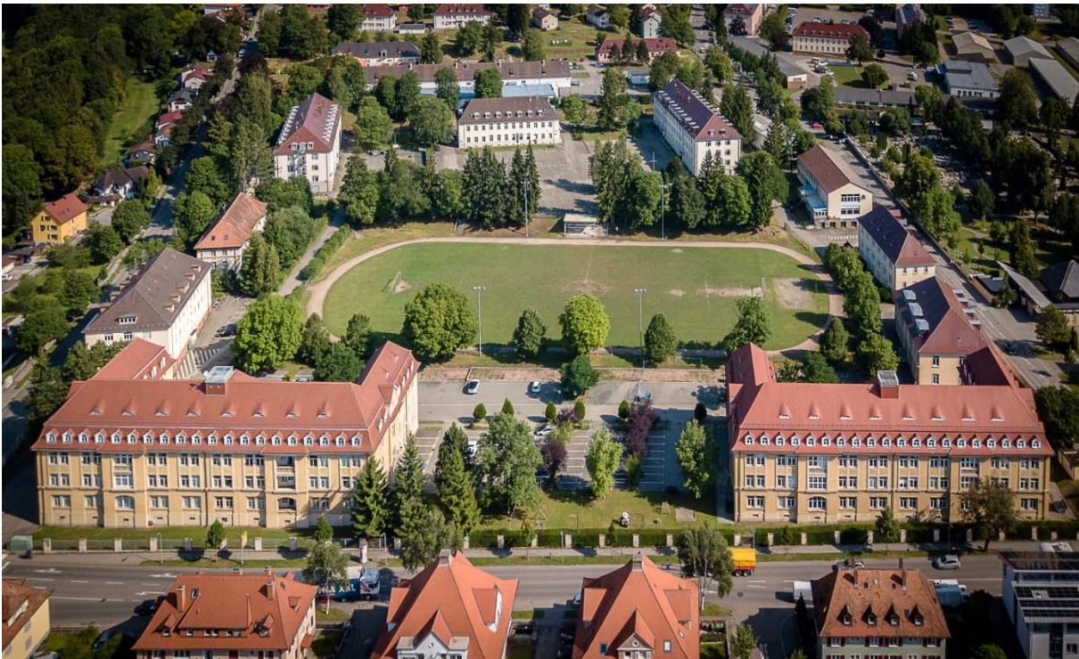
Abb. 9: Luftbild der ehem. französischen Kaserne (Quelle: SÜDWEST PRESSE vom 05.09.2020)
