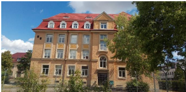
A: Blick auf östliches Militärgebäude
