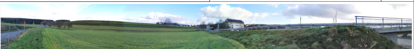
Ansicht aus Südwesten auf das Plangebiet. Rechts im Bild Überbrückung der K 5741 über die B27
