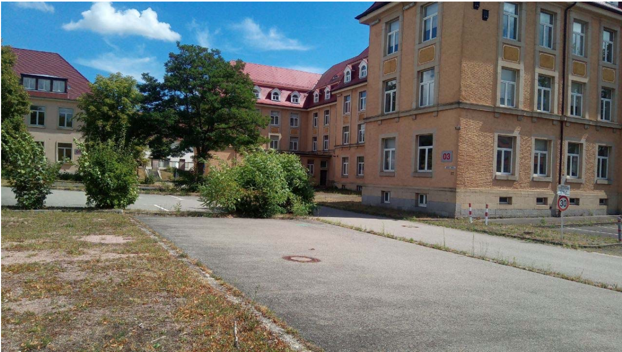
Abb. 8: Blick in den Innenhof des Kasernenareals (Quelle: bhm)
