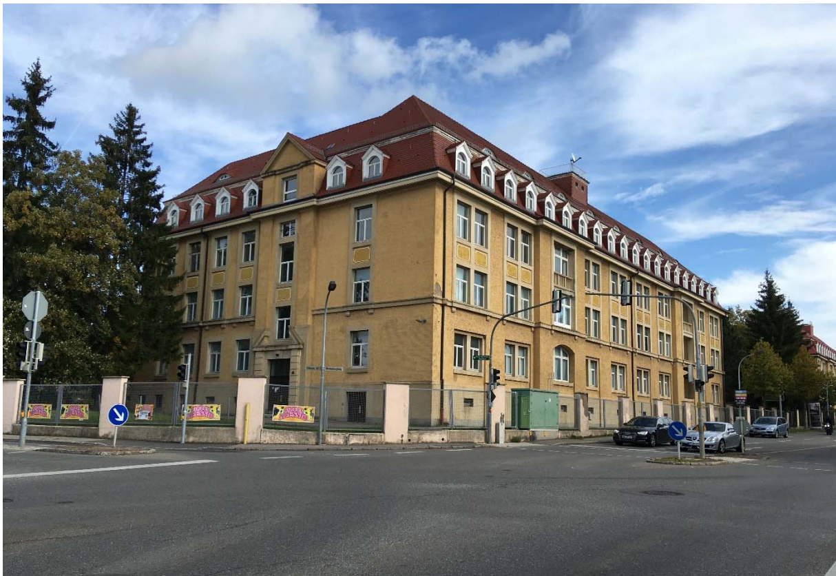
Abb. 6: Blick vom Hindenburgring auf das Kasernengebäude. (Quelle: bhmp)
