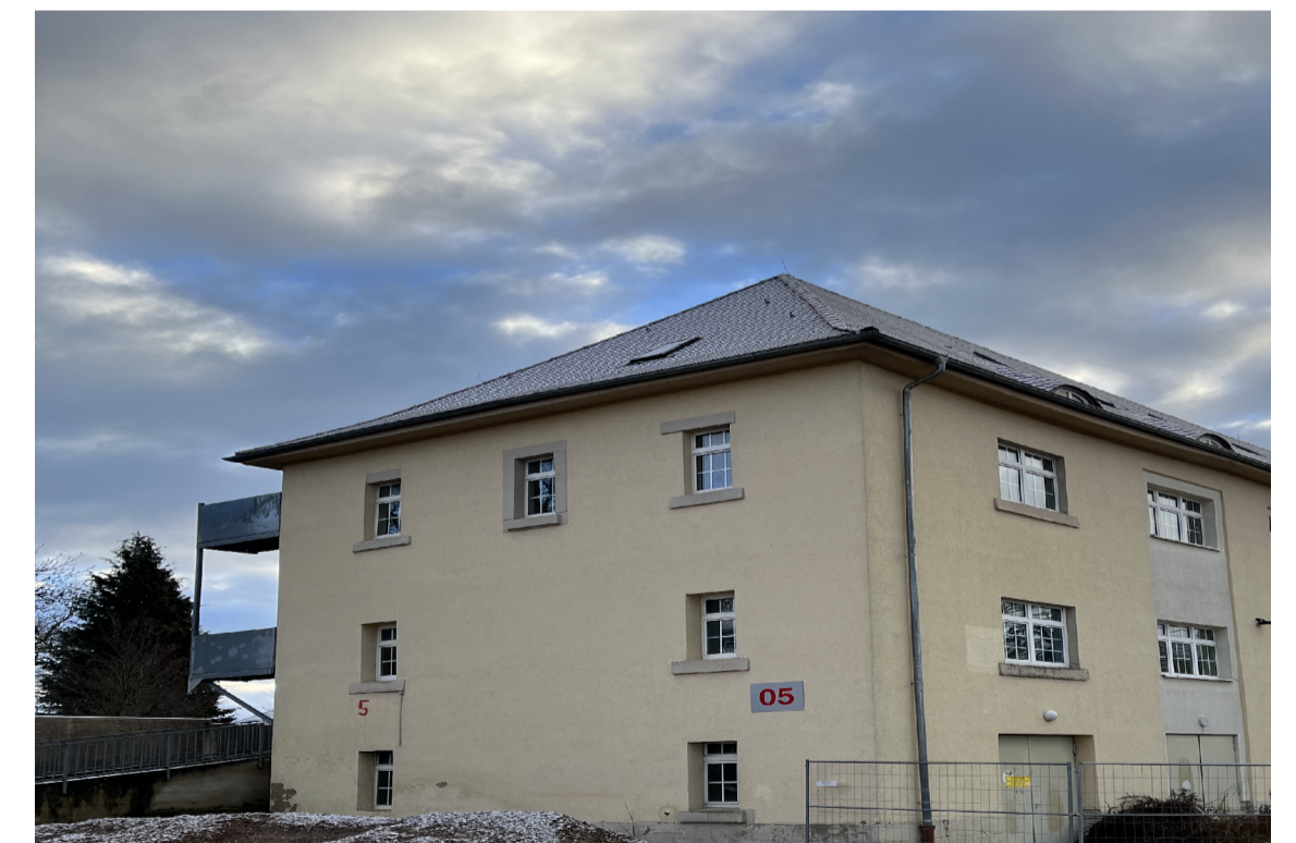
Haus 5 Denkmal Bestand Nordwestansicht
