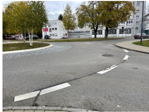
Abbildung 18: Foto der Situation
