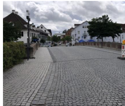
Abbildung 27: Foto der Situation
