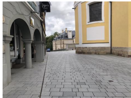
Abbildung 12: Foto der Situation
