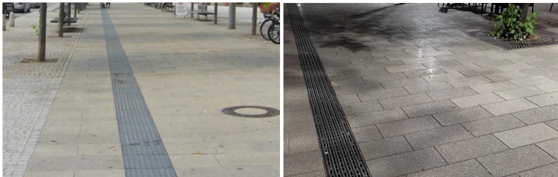
Abbildung 28: Beispiel für Blindenleitstreifen in Pflaster
