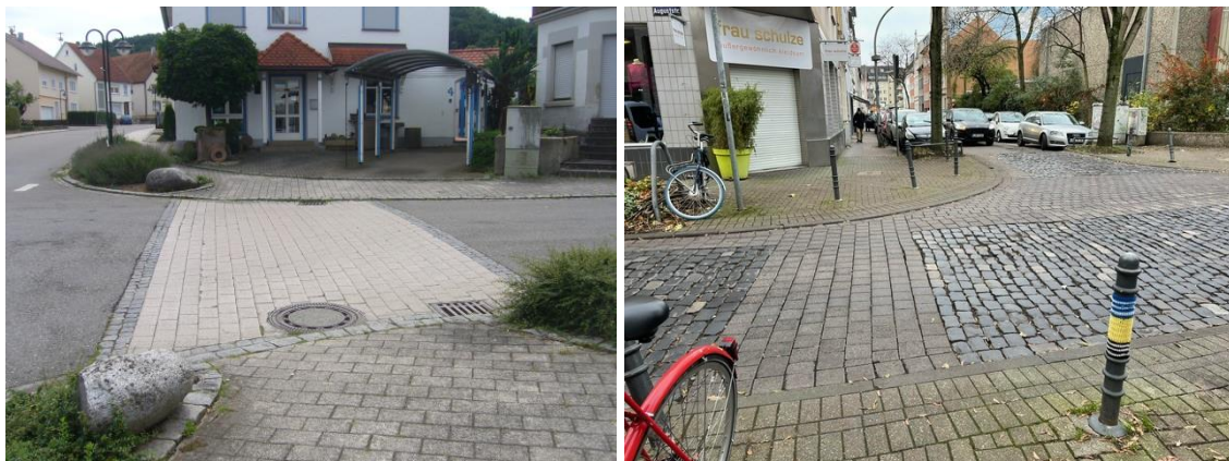
Abbildung 24: Beispiel für geeignetes Pflaster und Komfortband
