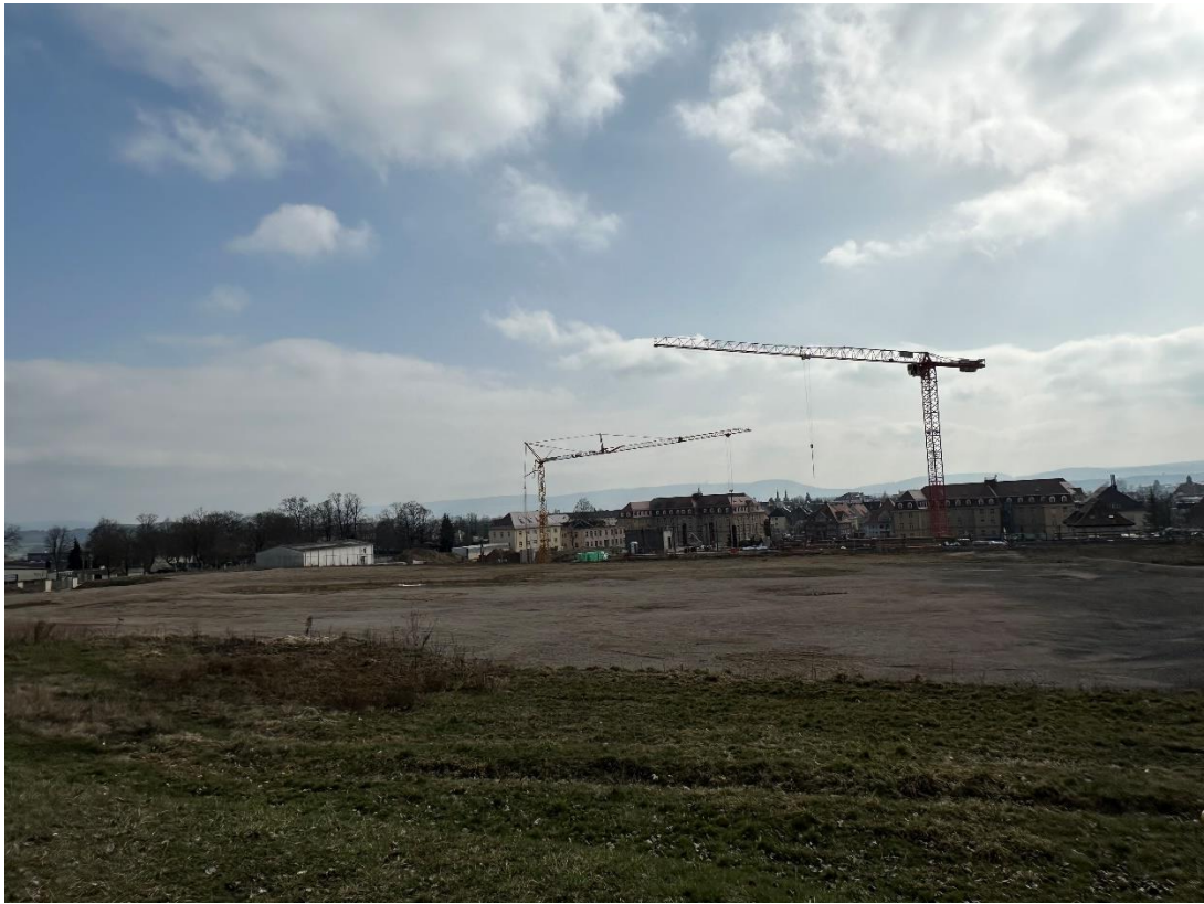
Abb. 3: Blick auf den vorhabenbezogenen Teil von Norden nach Süden Foto bhm.
