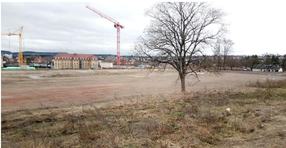
A: Blick Richtung Südwesten auf das Plangebiet
